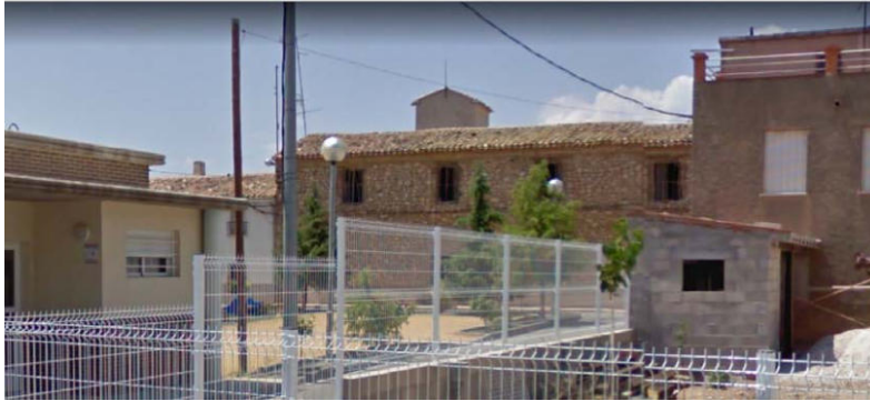
Vista parcial de la fachada de Bodegas Contreras.
